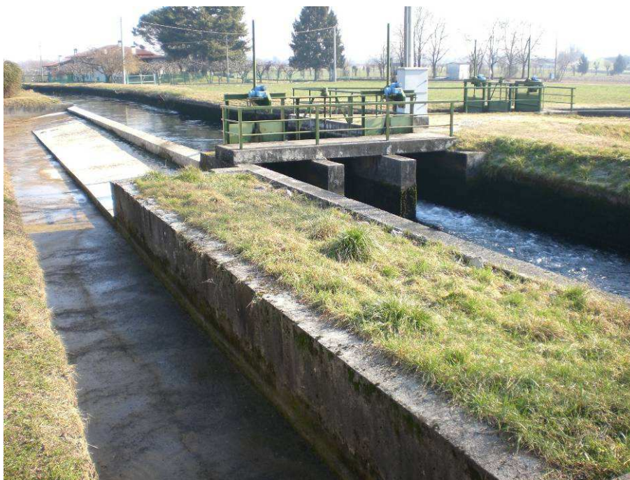
Figura 8. Nodo idraulico di diversione della Roggia Isacchina dal Canale Unico.
