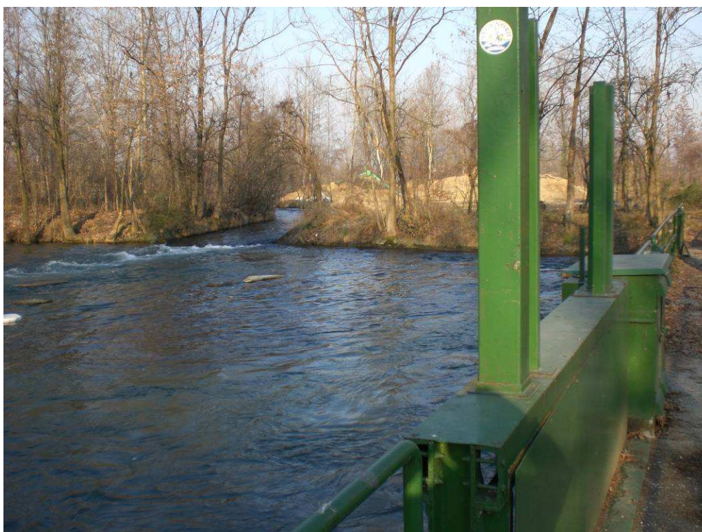
Figura 14. Vasca di accumulo e ripartizione delle portate tra lo Scarico Forca e la Roggia Dolfina Bernarda
