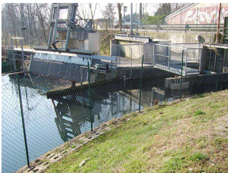
Figura 11. Sistema di regolazione mediante paratoie autolivellanti presente lungo il Canale Unico in località Crosara. Tale opera regima le portate turbinate attraverso una centralina ad acqua fluente.
