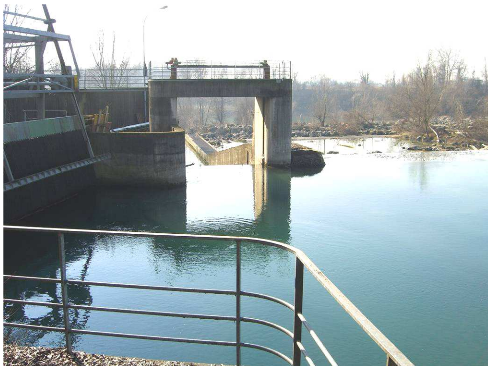
Figura 16. Opera di presa della centrale idroelettrica di Carturo. In tale sezione è presente una traversa che interessa l'intero alveo del fiume Brenta, lateralmente a questa è presente l'opera di presa della centrale regolata mediante paratoie autolivellanti al fine di mantenere un livello idrometrico il più costante possibile a monte dell'opera stessa.
